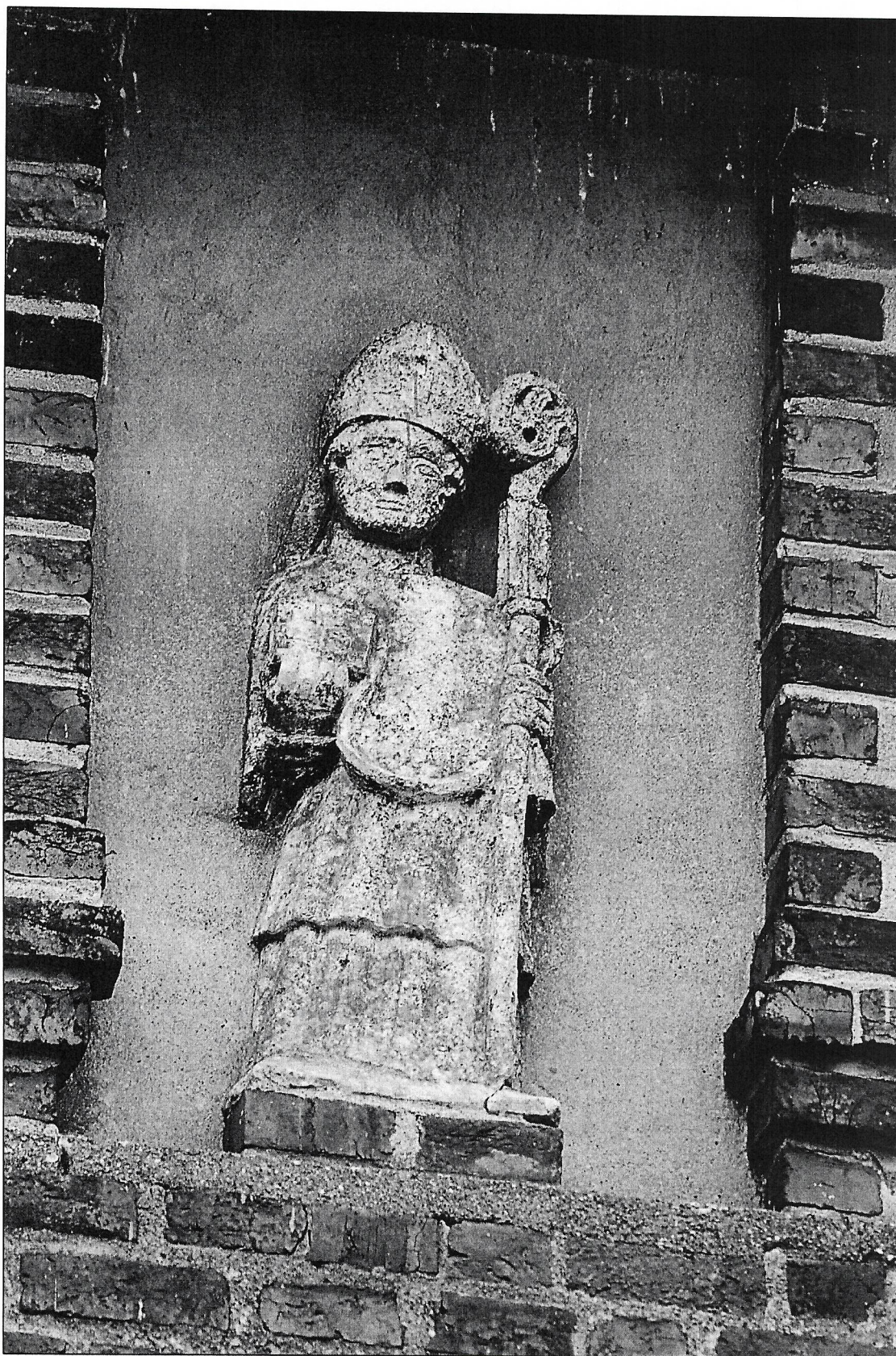
Fot. 5. Fasada kościoła pw. Św. Mikołaja w Stawie. Rzeźba św. Jadwigi Śląskiej. Stan z 20.01.2023 r. Powierzchnia kamienia zabrudzona. Na powierzchni widoczne uzupełnienia z wcześniejszych napraw – dłoni, szata.
