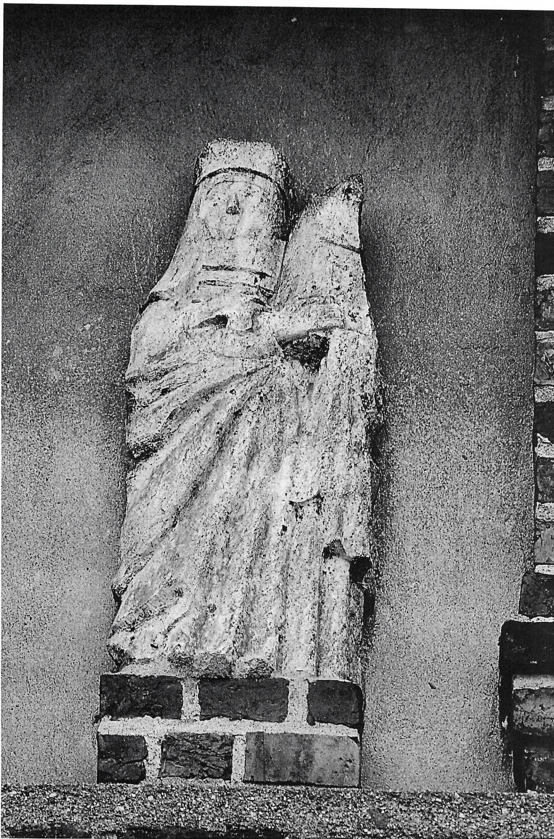
Fot. 4. Fasada kościoła pw. Św. Mikołaja w Stawie. Rzeźba św. Jadwigi Śląskiej. Stan z 20.01.2023 r. Powierzchnia kamienia zabrudzona. Na powierzchni widoczne uzupełnienia z wcześniejszych napraw.
