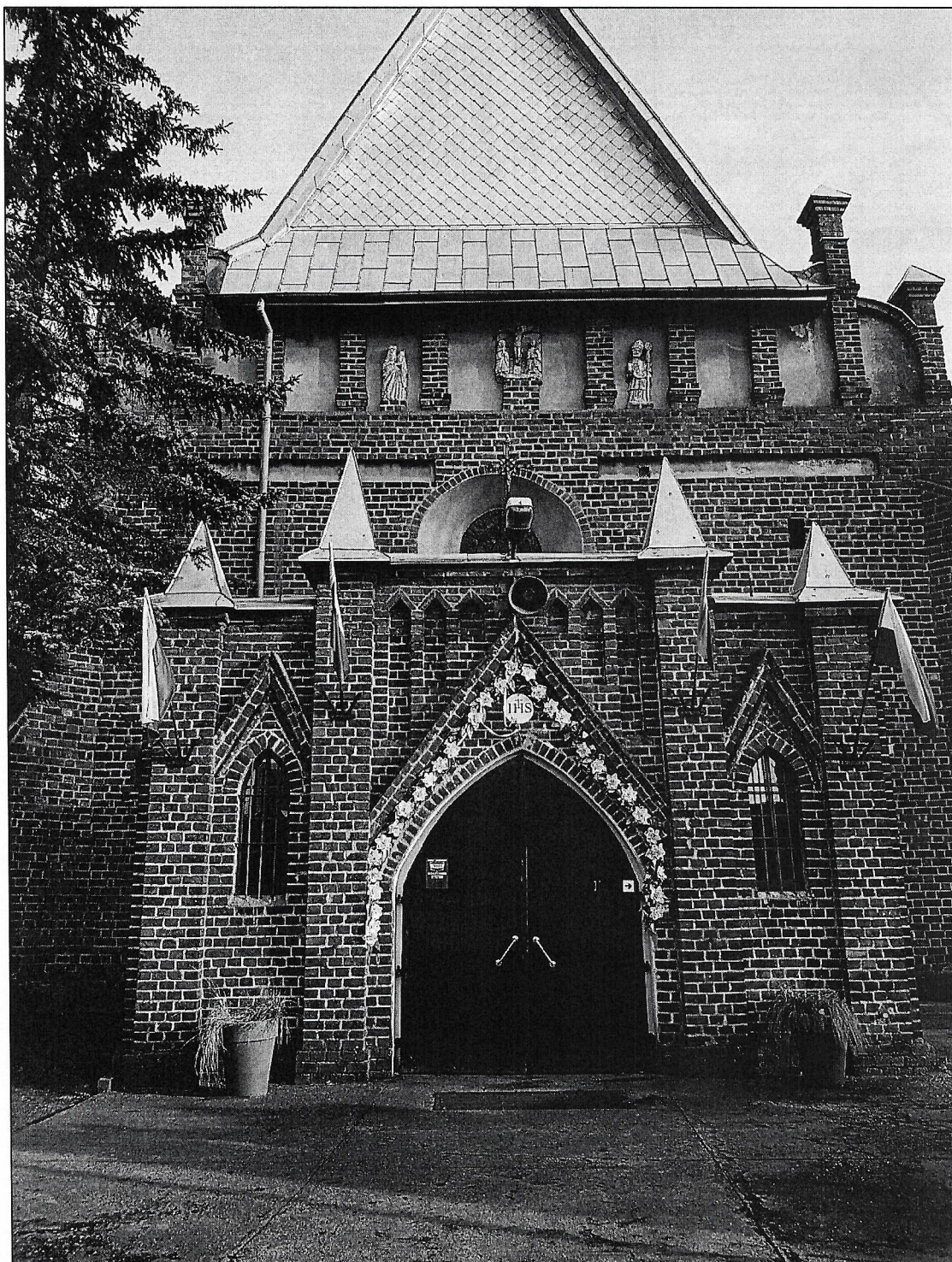
Fot. 1. Fasada kościoła pw. Św. Mikołaja w Stawie. Stan z 20.01.2023 r. w szczycie widoczne przedmiotowe kamienne rzeźby.
